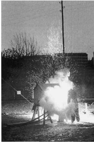
Kurzschluss in einer Schalttafel
